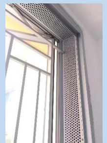
「減音窗」採用於景泰苑，而「強效減音露台」亦在柴灣漁灣邨漁進樓中採用。
